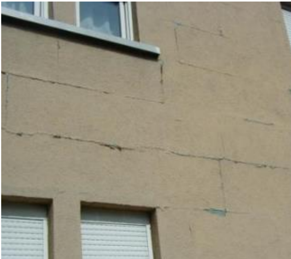
Липса на армираща мрежа в шпакловката
