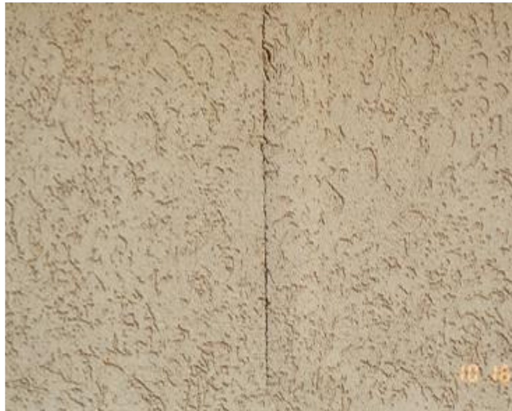
Положена армираща мрежа без застъпване
